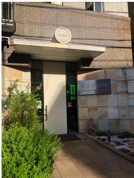
建物エントランス
